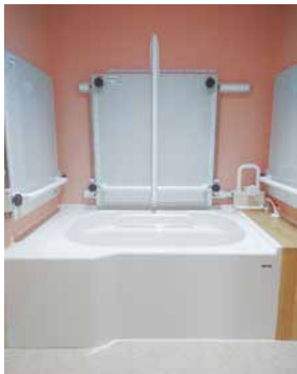
可動式手すりを装備した浴室
