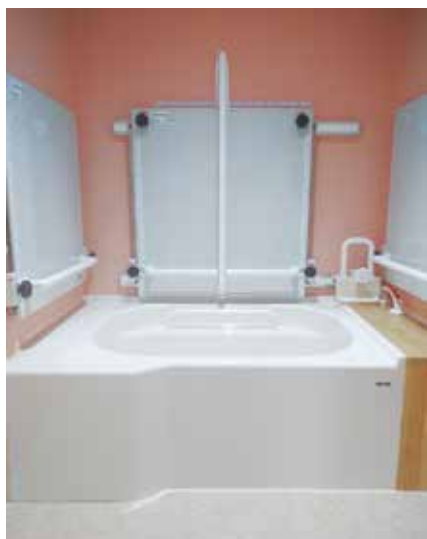
可動式手すりを装備した浴室
